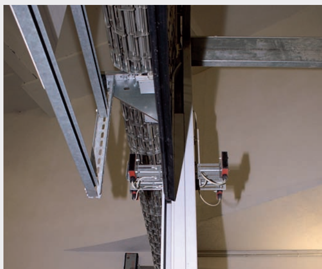
Zabezpieczenie przed wciągnięciem do kraty rolowanej
