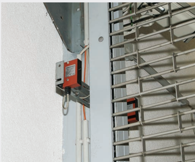
Zabezpieczenie przed wciągnięciem do kraty rolowanej
