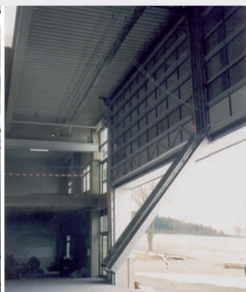
Bramy otwarte, podpora odryglowana, odchylająca się
