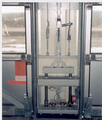
Widok podpory od strony wewnętrznej w stanie zaryglowanym, bramy zamknięte
