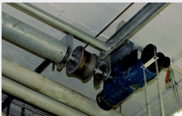
Wał rurowy z napędem elektrycznym IP 65. Wał napędowy zamontowany z tyłu (bez sprężyny skrętnej)
