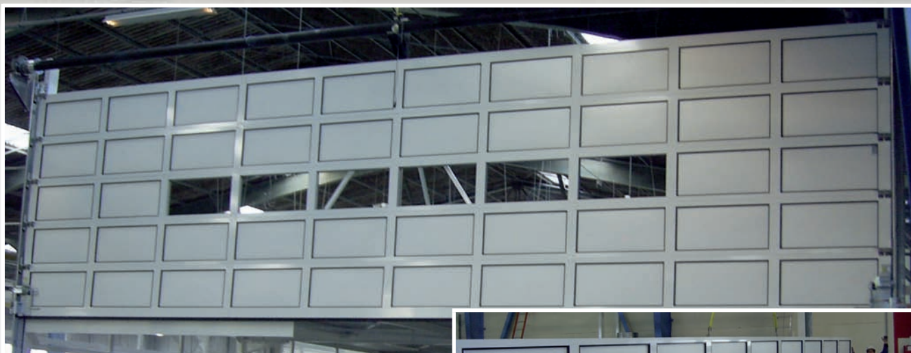
Górne zdjęcie: Brama XXL 707, 12500 x 8000 mm (szerokość w świetle x wysokość w świetle)
