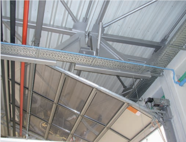
Prowadzenie standardowe wzdłuż konstrukcji dachu
