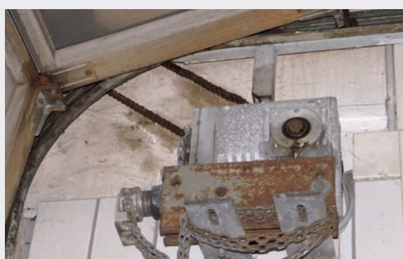
Wał sprężynowy i napęd łańcuchowy zamontowany z przodu
